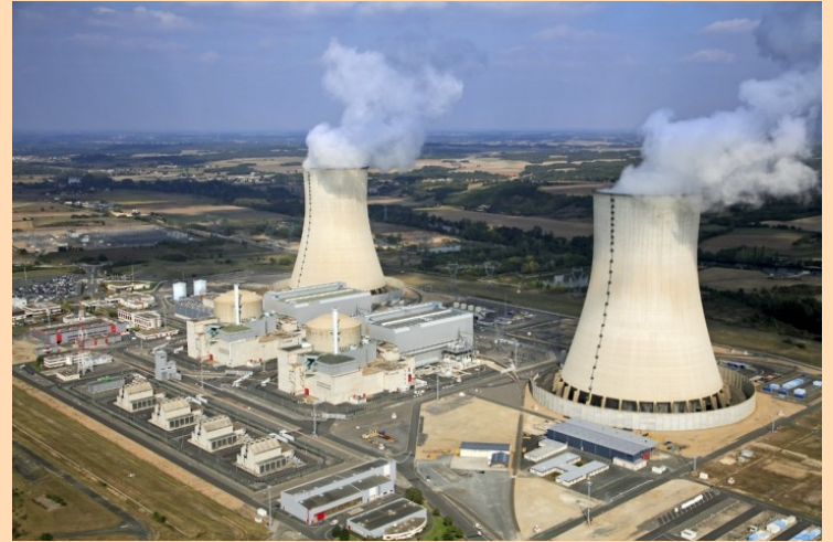
Centrale nucléaire de Civaux
